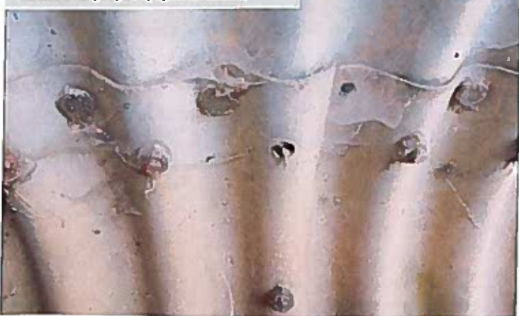
Detail překorodování nosné konstrukce ve spodní části tubosideru.
