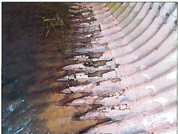
Detail překorodování nosné konstrukce ve spodní části tubosideru.
