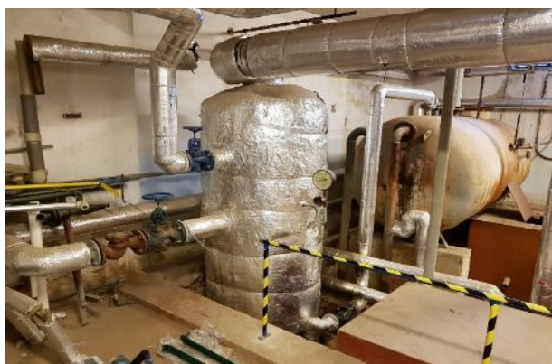
obr. vybavení výměňkové stanice – kondenzátní hospodářství
