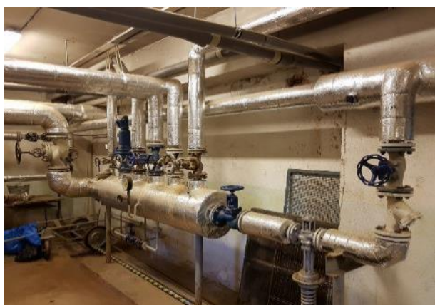
obr. vybavení výměňkové stanice, parní rozvaděč
