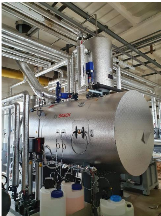
obr. napájecí nádrž s odplyněním
