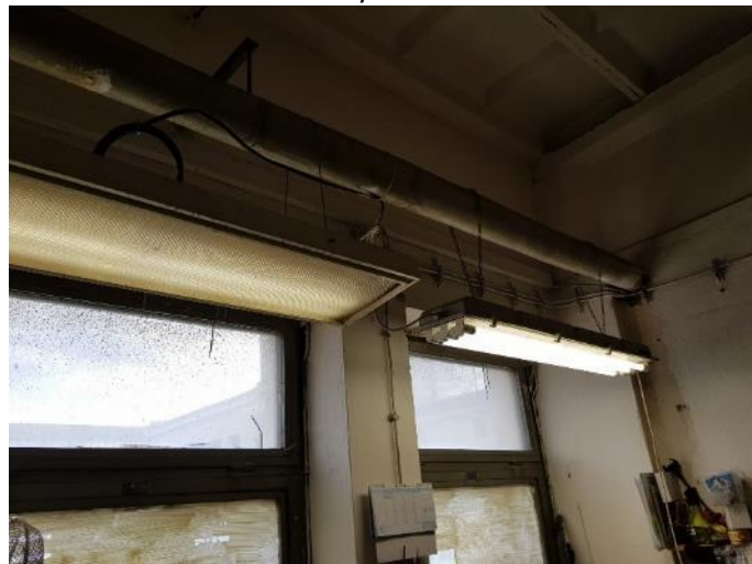
obr. Původní okna v kovových rámech
