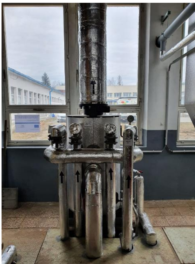
obr. expandér odluhu a odkalu
