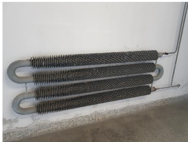
obr. použitá otopná tělesa
