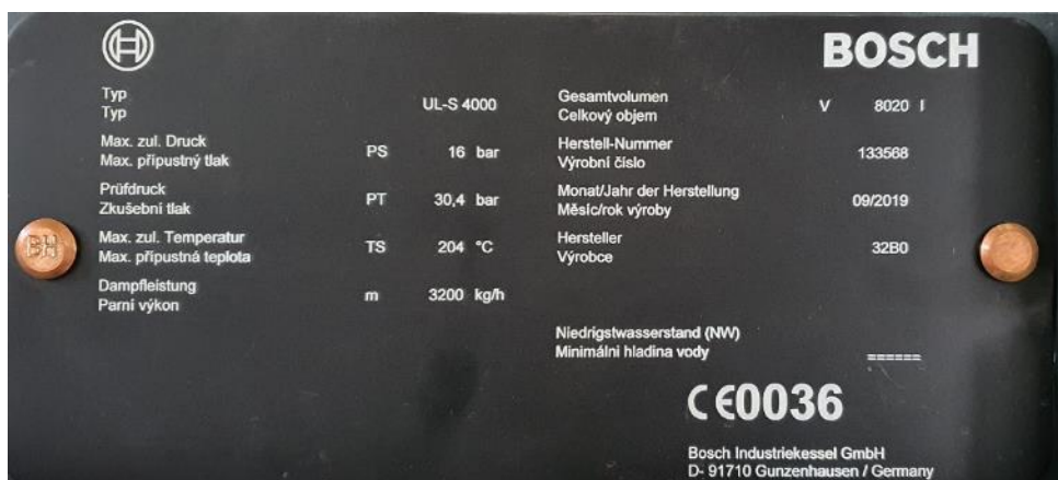
obr. štítek kotle K2
