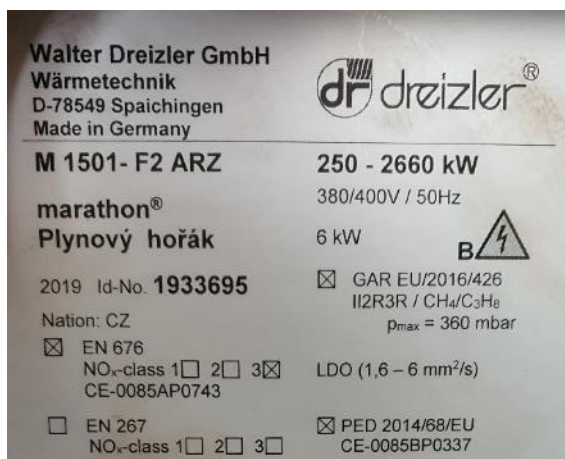
obr. štítek hořáku kotle K1
