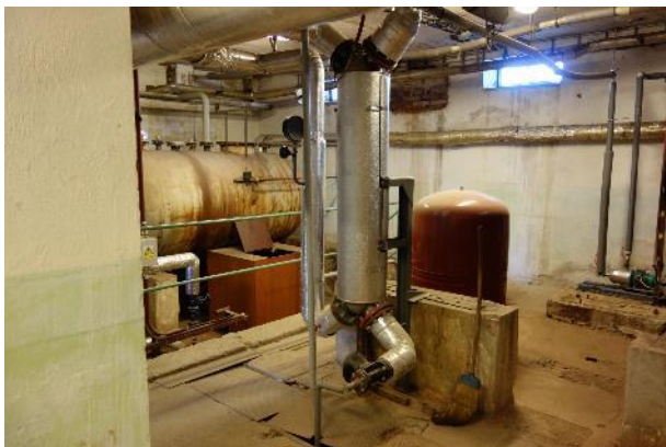
obr. výměník pro ÚT, ohříváče TV
