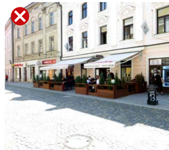
Nevhodně výrazná konstrukce oplocení.
