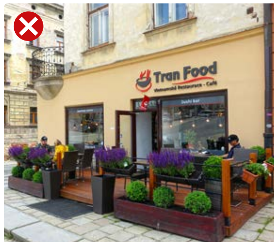
Provozní bariéra ve veřejném prostoru.
