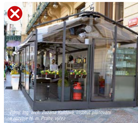
Nepatřičná privatizace části veřejného prostoru soukromou stavbou.
